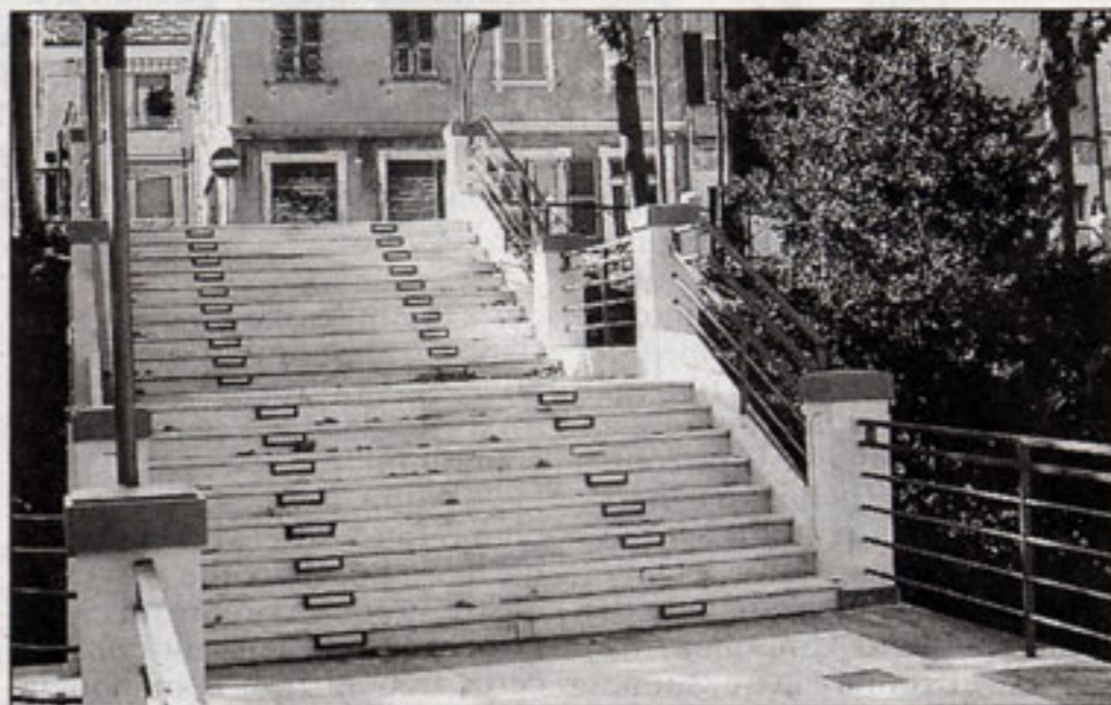
La scalinata del cinema Astra restaurata
